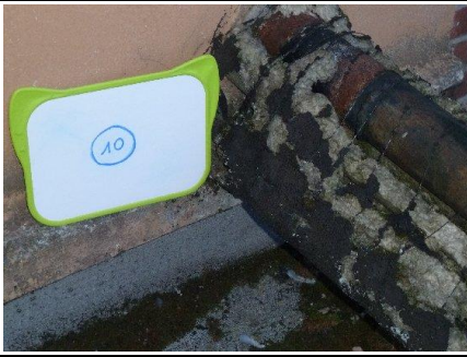
Photo n° Ph10 Localisation : Toiture - Terrasse Ouvrage : Équipements divers et accessoires - Tuyauteries Partie d'ouvrage : Calorifugeages Description : Calorifugeages
