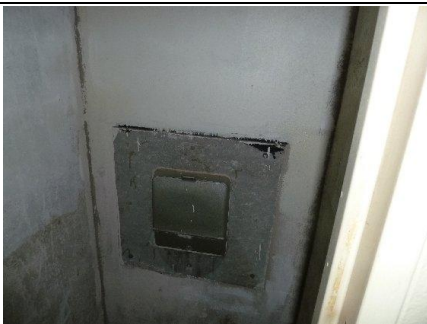
Photo n° PH03 Localisation : Étage 1 - Local poubelle Ouvrage : vide-ordure Partie d'ouvrage : Plaque de protection Description : Fibre ciment
