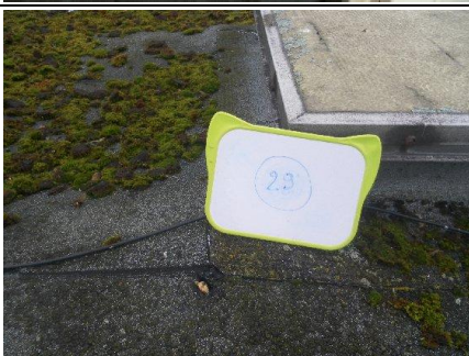
Photo n° PH04 Localisation : Toiture - Terrasse Ouvrage : Toiture, terrasse et étanchéité - Bardeaux bitumé (type Shingle) Partie d'ouvrage : Bardeaux bitumé Description : Bardeaux bitumé Localisation sur croquis : PH04
